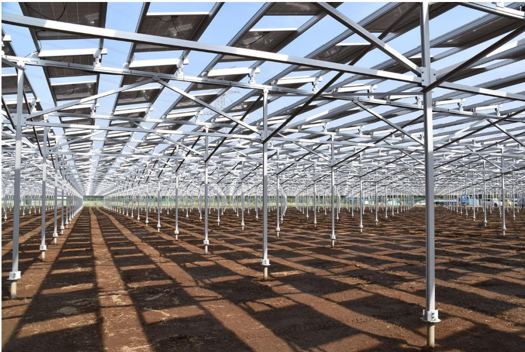
千葉市大木戸アグリ・エナジー 1 号機 現地写真
